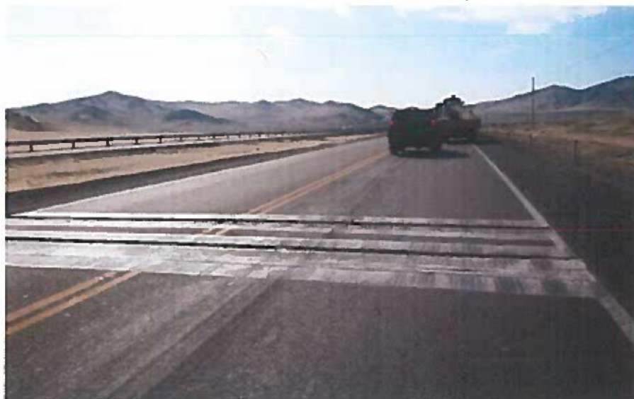
Fotografía 2: Bandas de fresado en operación
