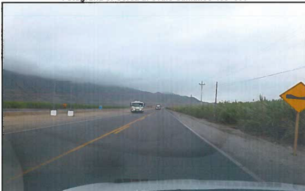
Fotografía 6: Cerca al óvalo Samanco 408+500
