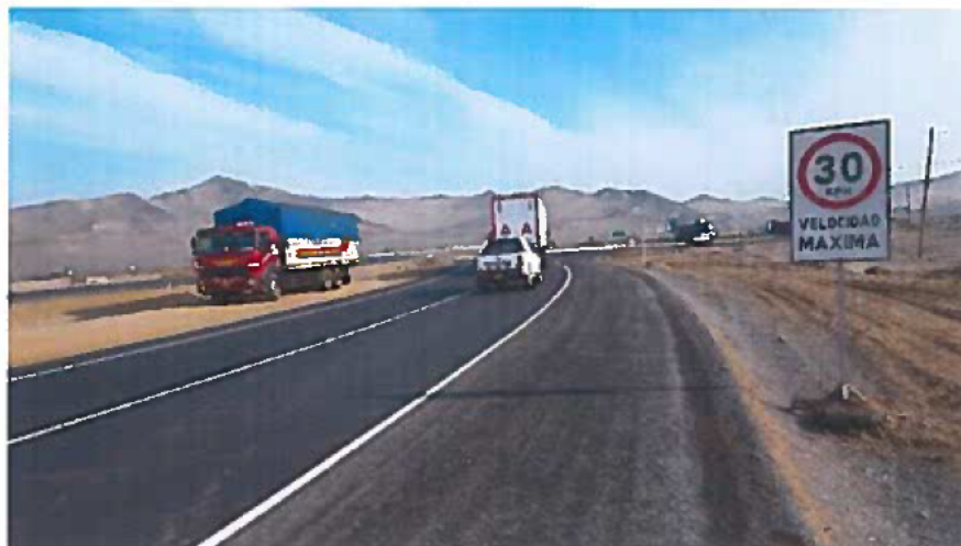
Fotografía 1: Señal Reglamentaria Vmax= 30KPH
