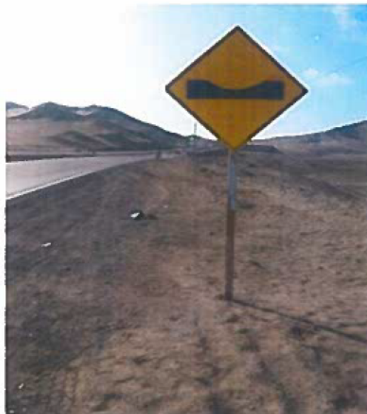
Fotografía 3: Señalización preventiva de Bandas de fresado
