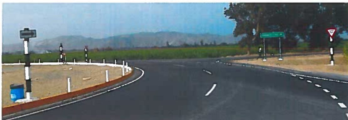
Óvalo de Samanco, señalizado con marcas en el pavimento, postes delineadores, señales informativas y reguladoras de "CEDA EL PASO".
