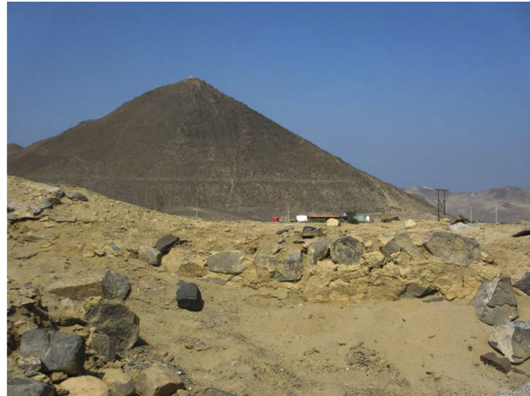
Figura 43. Vista de Cerro Nepeña (Cerro Popo), desde el sitio Huambacho. Nótese en primer plano la construcción de un muro, con la técnica de ortostatos, similar a los registrados en Cerro Nepeña .
